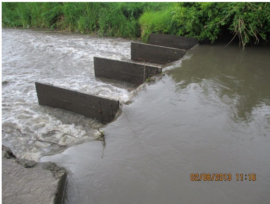
Obr. 71 Počátek reakce toku na srážky dne 2.6.2013 dopoledne a záběr na stavidlo po obci Hronětice, NB v otevřeném stavu s mírnou náplavou nečistot vlivem povodně
