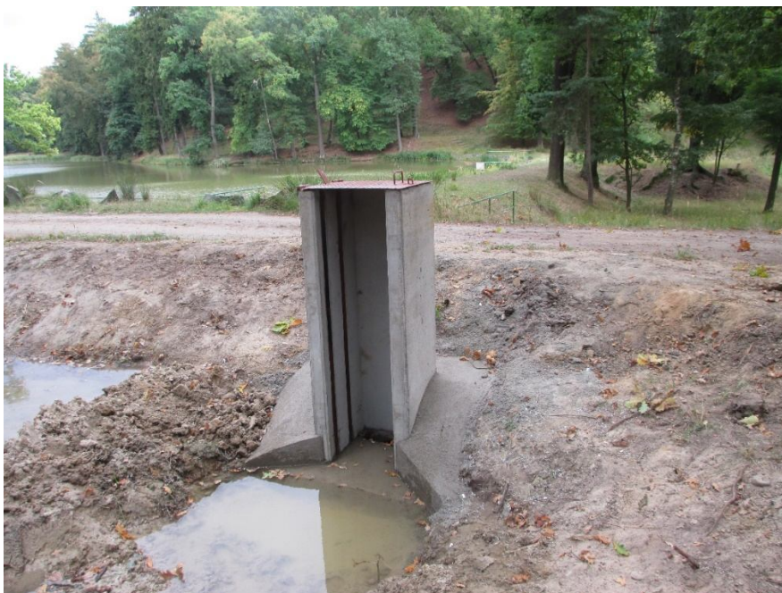
Obr. 19 Výstavba umělých nádrží v povodí Jabkenického potoka (rok 2015)
