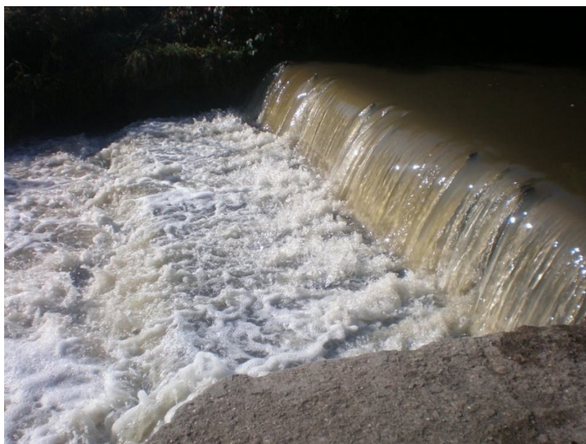
Obr. 49 Vyšší průtok na dolní Vlkavě v podzimním období zapříčiněný vypouštěním rybníků v horní části toku (Hronětice, 2012)
