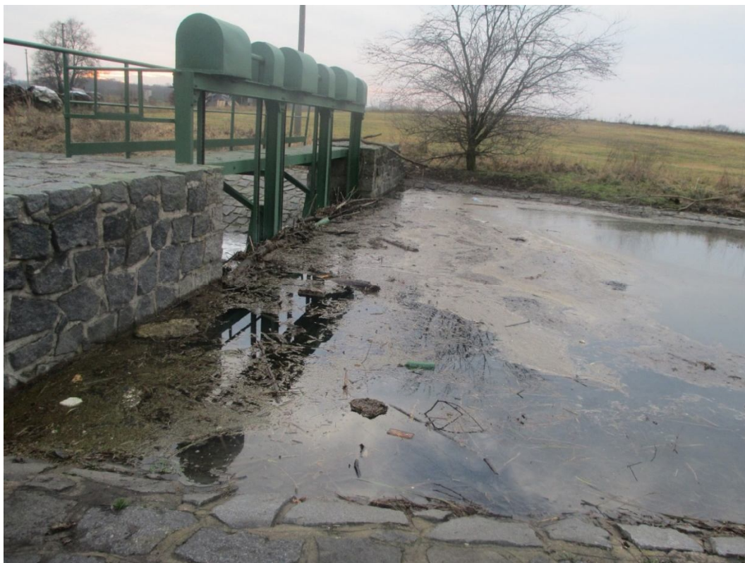
Obr. 51 Značně ucpaný přepad stavidla pod obcí Kostomlaty, NB v zimním období po vyšším průtoku a při delším nečištění stavidla – i proto je dnes stavidlo na zimu vyhrazováno. Ani v toku Vlkavy nejsou bohužel výjimkou skleněné a plastové odpady vedle materiálů jako produktu přírody (Prosinec 2013)
