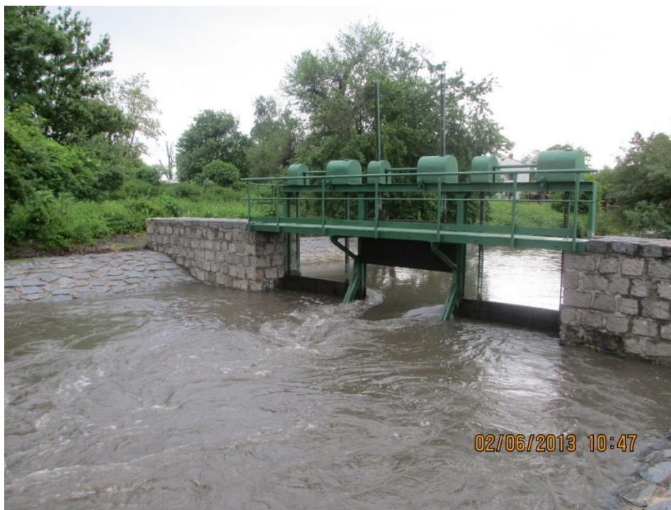
Obr. 72 Otevřené středové pole stavidla u části Kostomlaty-Lány, dne 2.6.2013 dopoledne
