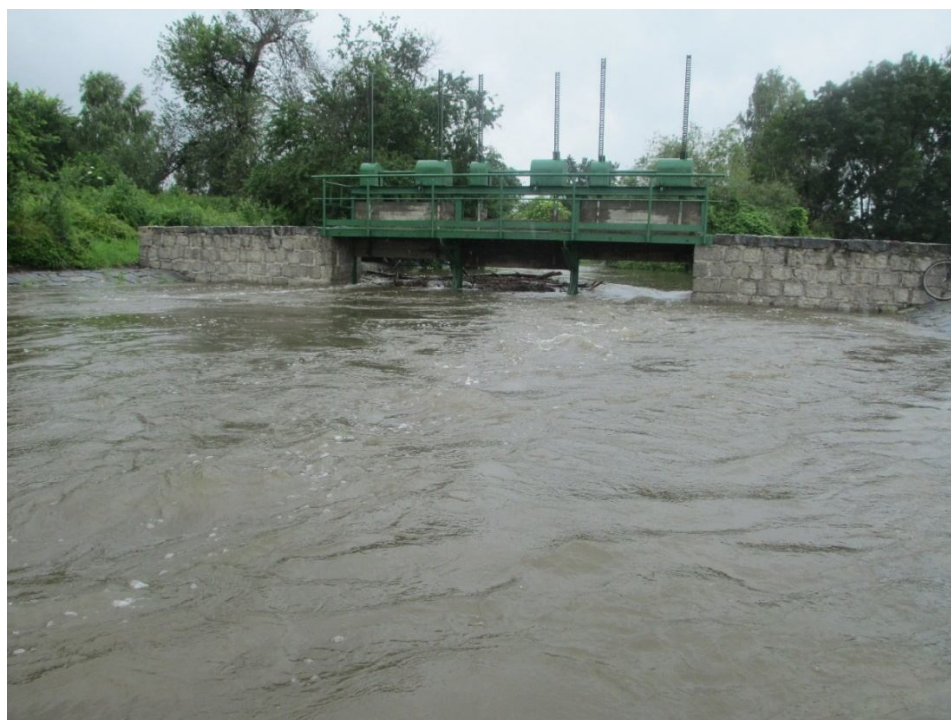
Obr. 75 Pokračování vzdouvání hladiny toku, pohled na zcela vytažená jezová pole stavidla Kostomlaty-Lány 26.6.2013 dopoledne
