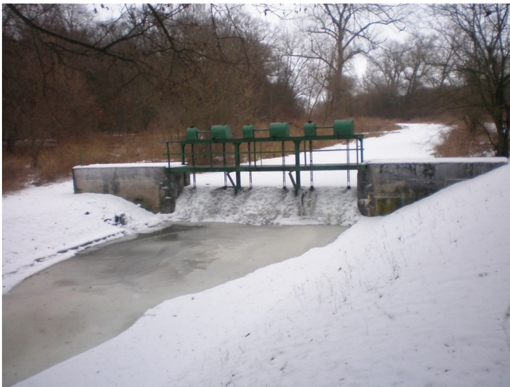
Obr. 101 Zámrz dolní části toku, včetně přepadu přes koncové stavidlo v únoru 2012
