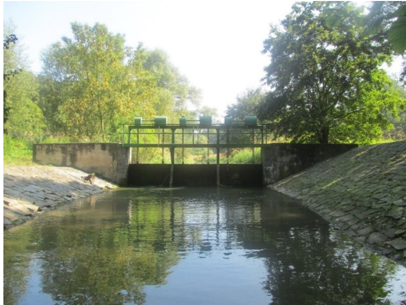
Obr. 38 Uzavřené poslední stavidlo za běžného vodního stavu, veškerá voda, kromě průsakové vody pod stavidlem odtéká Farským potokem (odbočka kousek nad stavidlem na pravém břehu toku)
