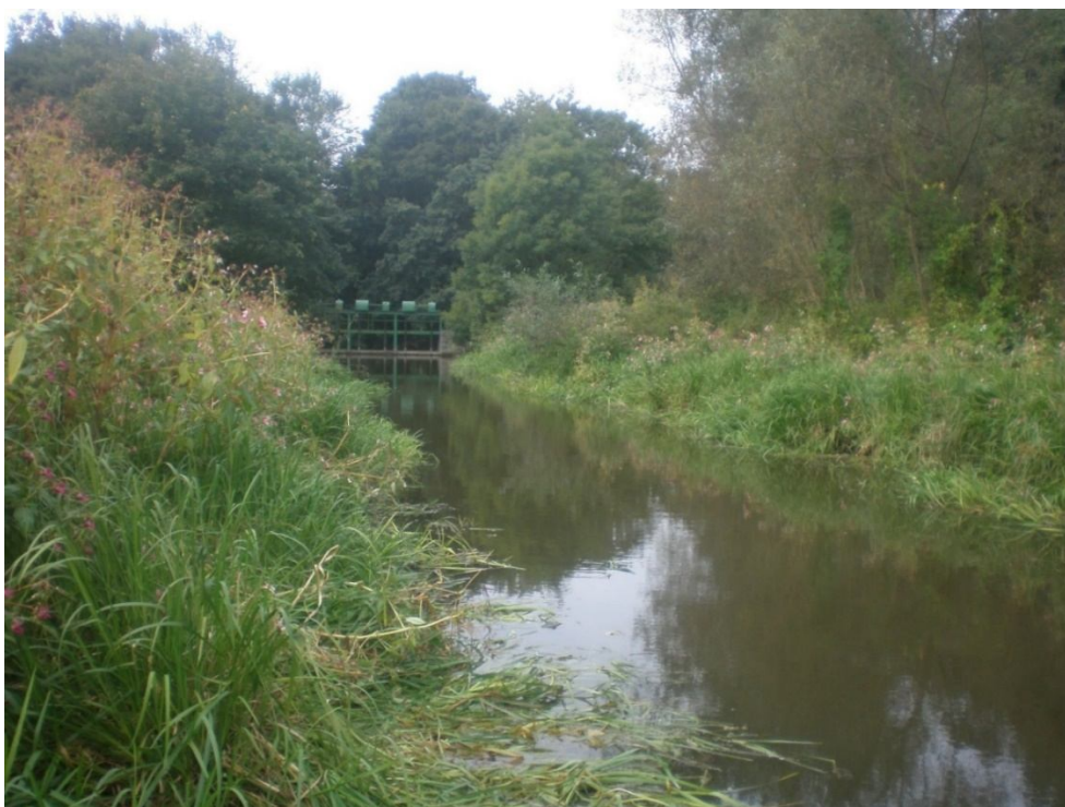
Obr. 35 Pohled na koncové stavidlo, které zajišťuje průtok Farským potokem, foceno za nižšího vodního stavu, kdy je až na průsaky vody spodní částí stavidla, strouha bez průtoku vody
