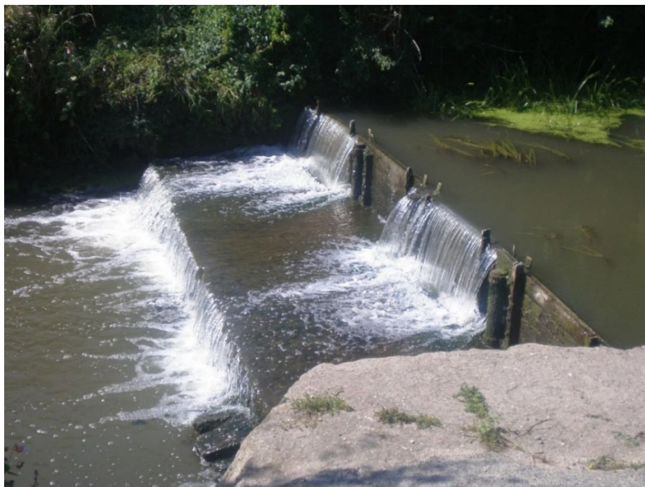
Obr. 48 Nižší vodnost toku v jeho dolní části na konci léta (Hronětice, 2012, pozn. původní stavidlo, které bylo rekonstruováno – v roce 2013)
