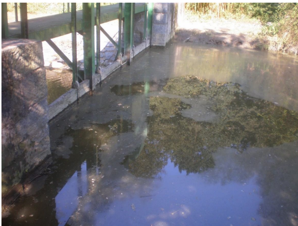
Obr. 52 Zhoršená jakost vody u koncového stavidla za dosti nízkého stavu vody, kdy veškerou vodu odebírá Farský potok. Voda nepřepadá přes stavidlo, tvoří se povrchové nečistoty. Pokud trvá situace nízké cirkulace vody déle, pokračuje zhoršování jakosti (Září 2012)
