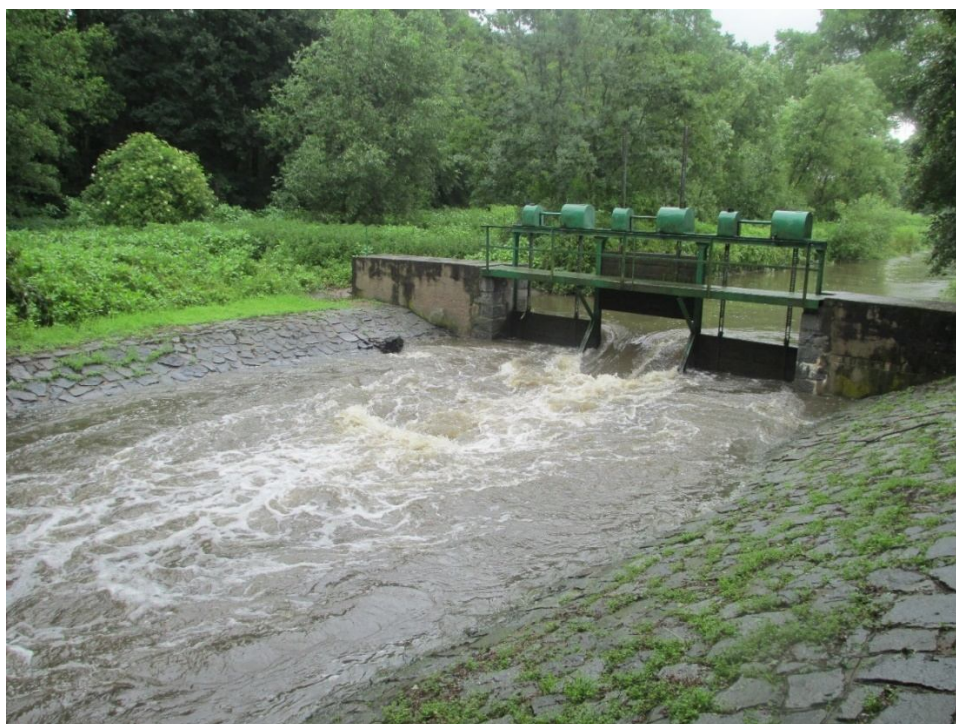
Obr. 79 Poslední stavilo za odbočkou (Farský potok) při povodni 26.6.2013, kdy je prostřední část stavidla zdvihnuta pro volnější odtok velkého množství vody, i přesto je vodný Farský potok, hladina prakticky na normálním stavu za spuštěného stavidla, vlivem vysokého průtoku
