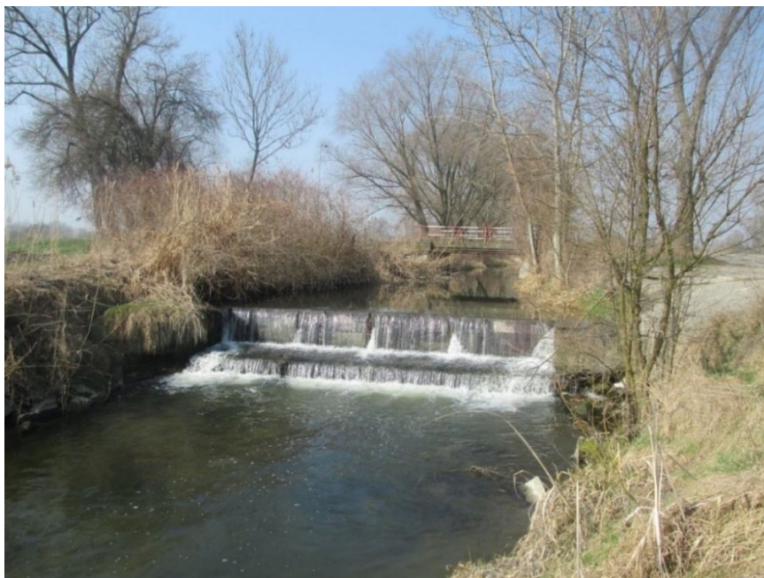
Obr. 29 Uzavřené malé stavidlo pod obcí Hronětice, NB
