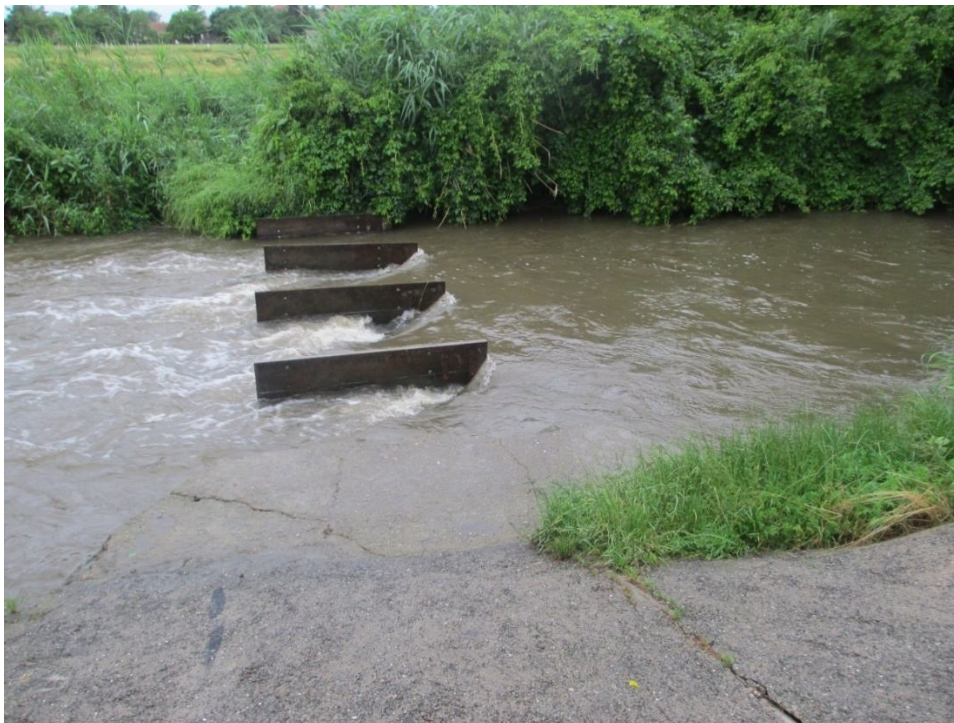
Obr. 74 Pohled na otevřené stavidlo pod obcí Hronětice, NB při reakci toku na srážky, 25.6.2013 večer
